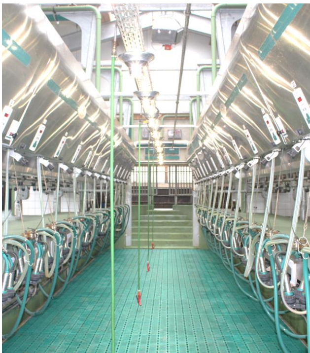
LED-Beleuchtung Melkstand (Leuchtturmveranstaltung Hessen)
