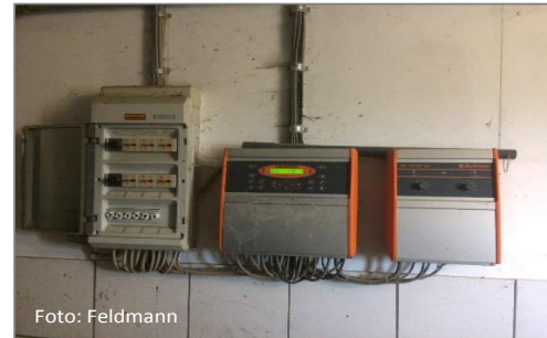
Alte Regeltechnik der Lüftungsanlage
